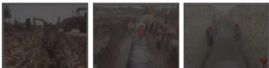
**Figura 16.** Colocación y compactación simétrica por capas.
