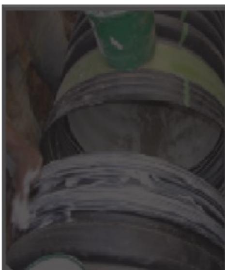
**Figura 14.** Colocación de lubricante.
